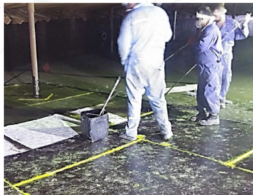
▲ اجرای پوشش کامپوزیتی در کف مخزن
